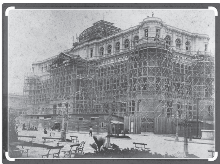
Figura 5 - Construção da Biblioteca Nacional - 1909
